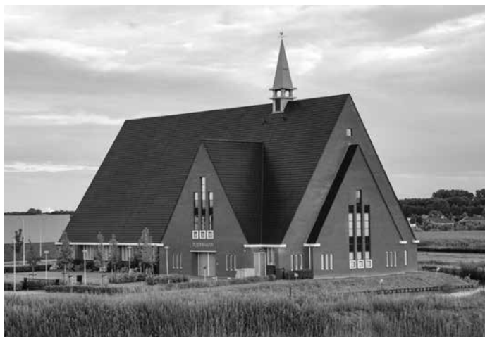
Exterieur van de Zuiderhavenkerk in Barendrecht.
