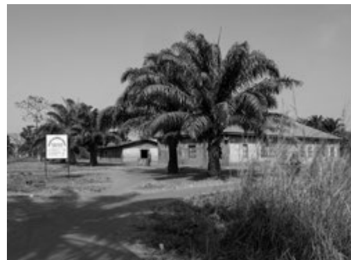
Kerkgebouw Nigeria Reformed Church, Iseke
